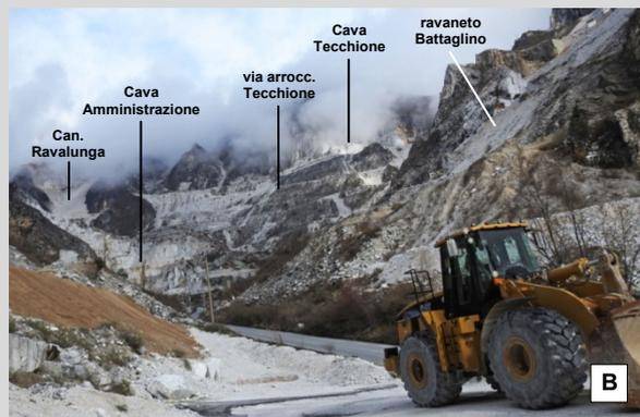
**Fig. 2.14.** Vista del bacino di Ravaccione da Poggio Dovizia: confronto tra i primi anni del '900 (A) e oggi (B). Si noti che i vecchi ravaneti (Lorano e Battaglino) erano molto più rigonfi di oggi e costituiti da sole scaglie (non sono visibili terre).
