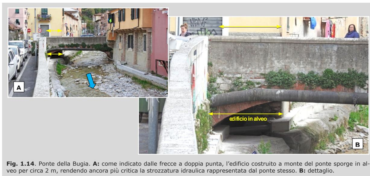
**Fig. 1.14.** Ponte della Bugia. **A:** come indicato dalle frecce a doppia punta, l'edificio costruito a monte del ponte sporge in alveo per circa 2 m, rendendo ancora più critica la strozzatura idraulica rappresentata dal ponte stesso. **B:** dettaglio.
