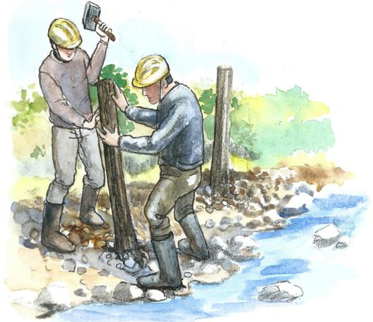
Dove era necessaria una struttura di rinforzo si scelse di utilizzare pali di legno conficcati nel terreno. Le rive vennero totalmente ripiantumate.
